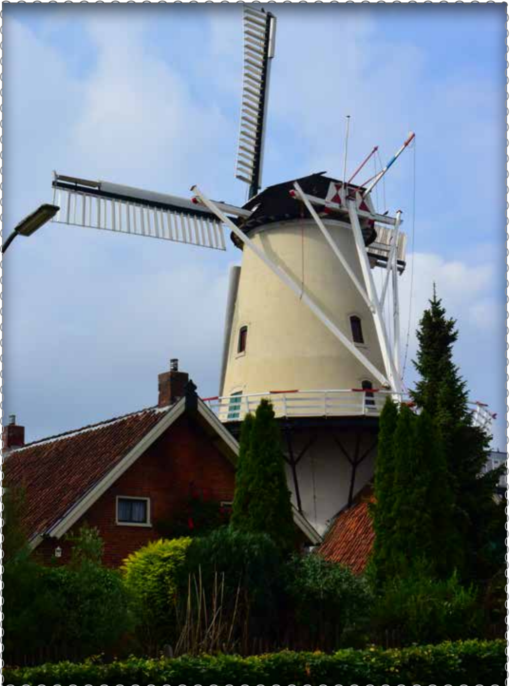
Molen De Hoop is gebouwd als korenmolen in 1839, later werd het een oliemolen. Nu met ingebouwde motor. Het is een zogenaamde bovenkruier met stenen onderbouw. Samen met winkel, woning en schuren Rijksmonument. Zie: www.molendehoopharen.nl
