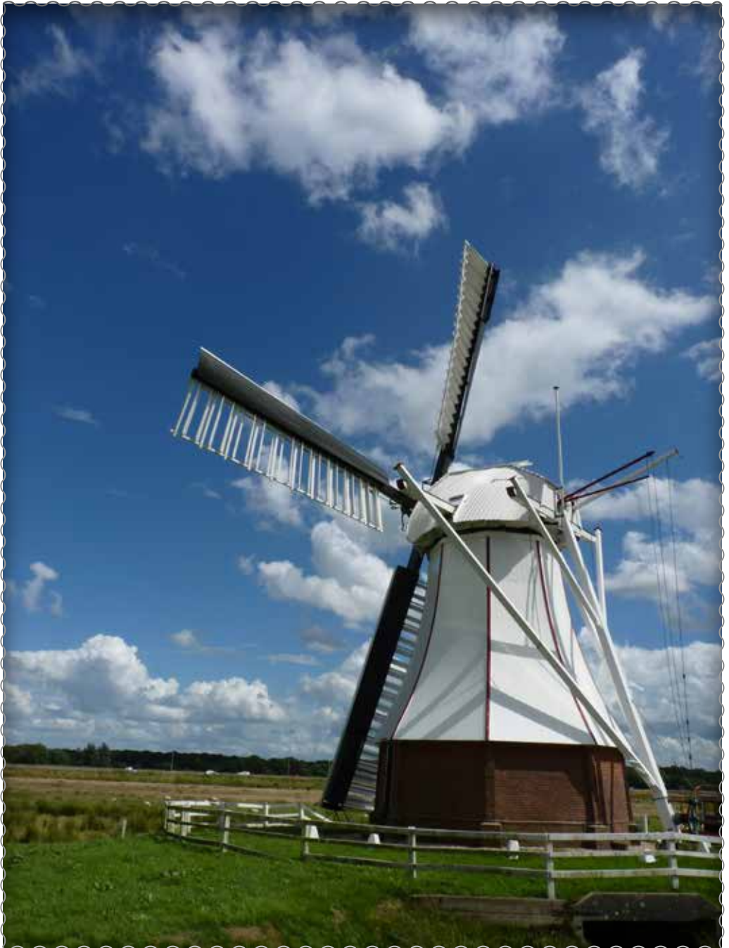
De Witte Molen: Gebouwd als achtkantige bovenkruier in 1892 om de polder Glimmen droog te kunnen houden. Het water wordt met behulp van een vijzel in het Noord-Willemskanaal gepompt. Aanvankelijk werd alleen windkracht gebruikt. Later werd er een motor in geplaatst.
